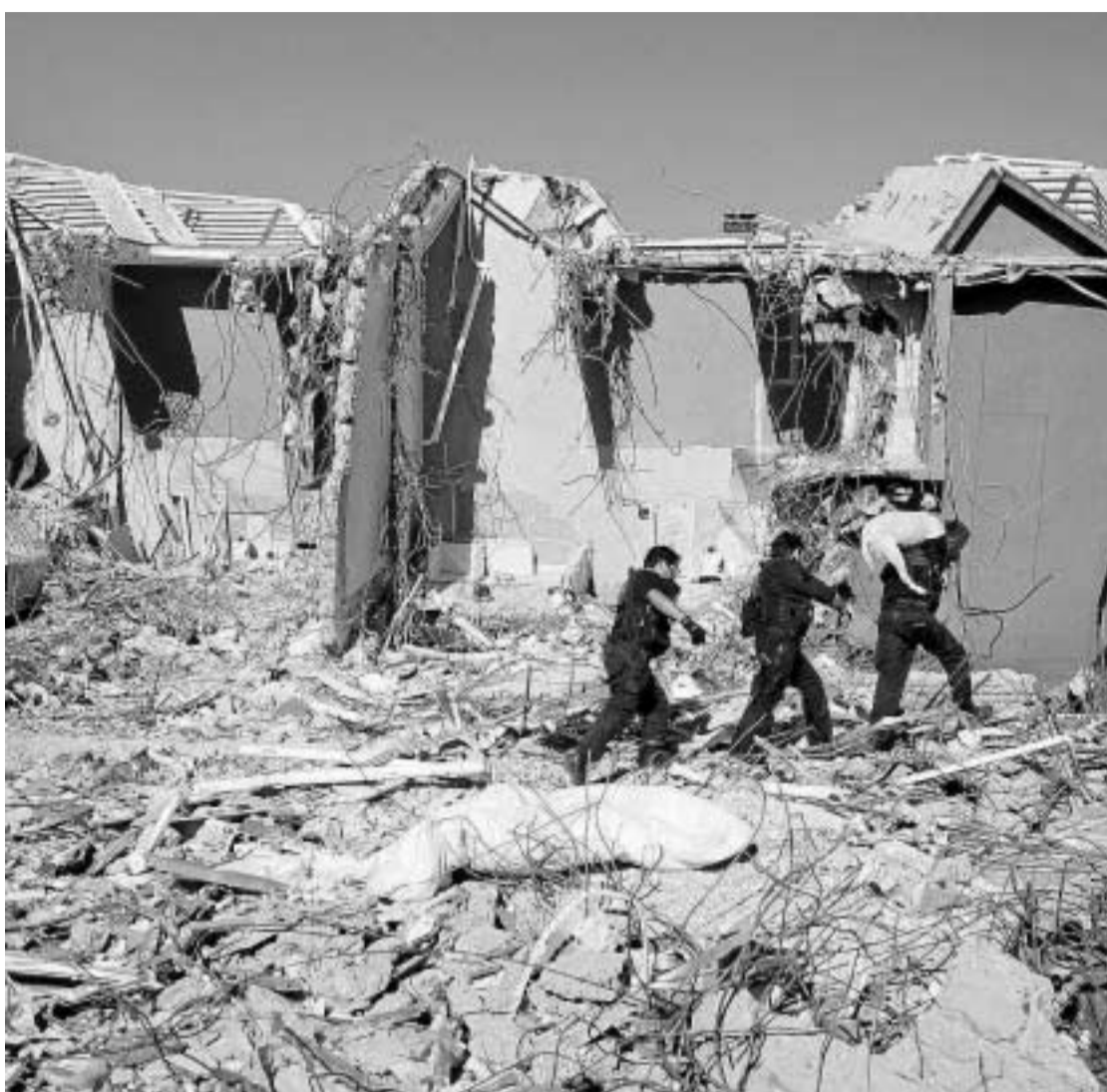
Imagen del 28 de febrero de 2010: labores de búsqueda en un edificio derrumbado en Concepción.
